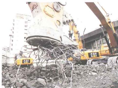
次に、高品質な2次解体ではガラがきれいなことも大切です。もちろん、この現場でも鉄筋回収率100%を実現しています。なぜできるのか、2次解体の作業時間の多くは鉄筋回収時間に費やされているから、そこを大きく短縮させるから時間に余裕が生まれているのです。その余裕時間を使ってより細かい小割作業をするのです。だから他の業者よりも細かくきれいなガラを作ることができるわけです。
