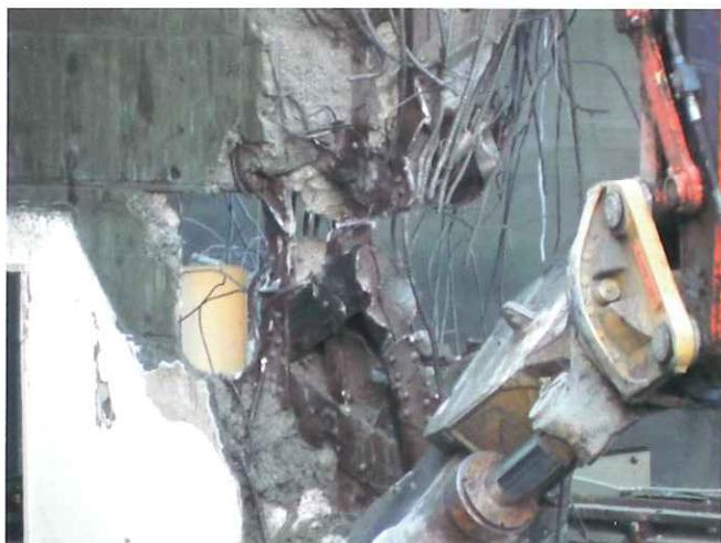
柱も簡単には倒れませんが、トラス構造の場合には必要以上に柱や梁を押す力を加えることは危険であり、トラス造ならではの強度の弱さが逆に作業に気を使わせている理由なのです。
