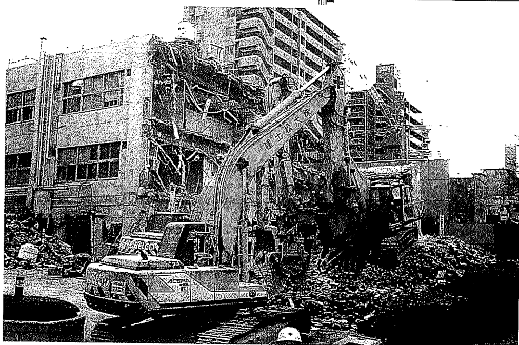
阪神・淡路大震災後の復旧工事現場。ビルの解体には多くの油圧解体機が活躍した
