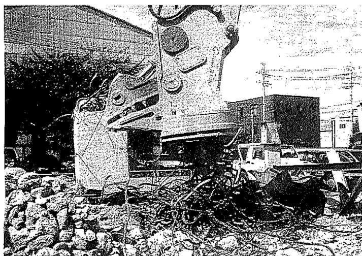
鉄筋をいかに効率よく回収するか―解体現場の悩みだ
