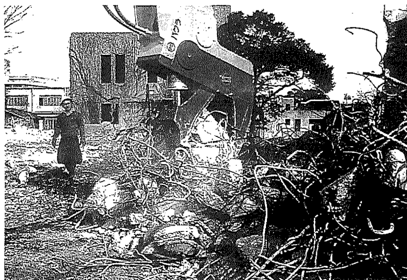
80年ごろの油圧解体機「パクラ」。先端部でコンクリート塊を掴み砕いた
