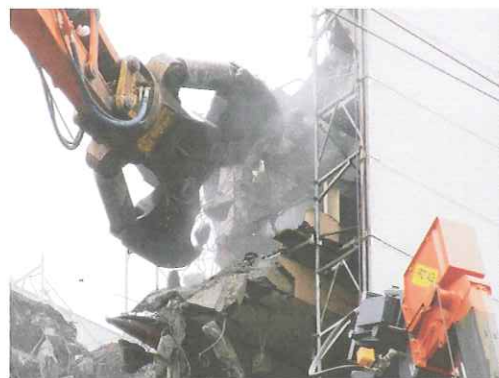
10階部分のSRC梁の破碎&切断中のSDS250 KATANA
