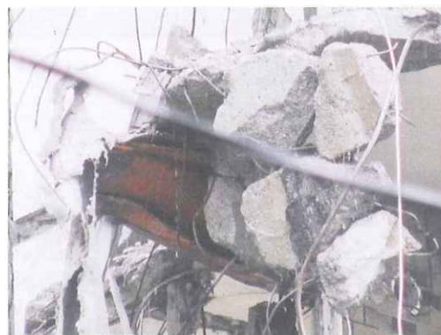
破碎切断後のH形鋼300mm
