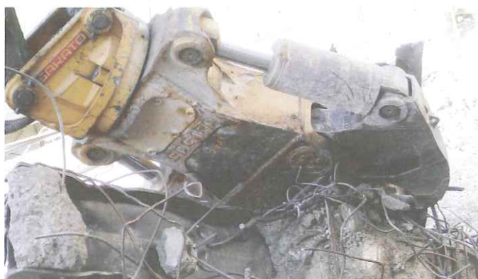
写真：SRC梁のH形鋼400mmを切断するSDS150 SRC-ARM
