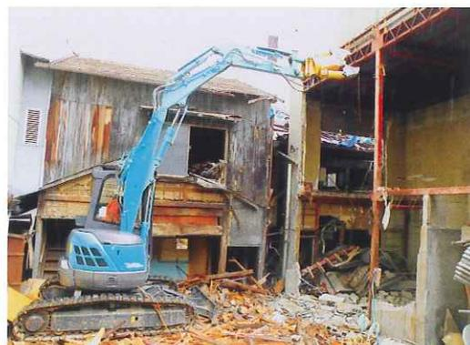
しかし課題として、解体機の性能が現場全てに対応できておらず、発展途上段階であるのです。どうかしてこの3トクラスバックホーに本格的な解体性能を持たせることを実現させ、手作業や従来レベル性能の解体機にとってかわる、本格的な機械解体が実現したかったのです。
