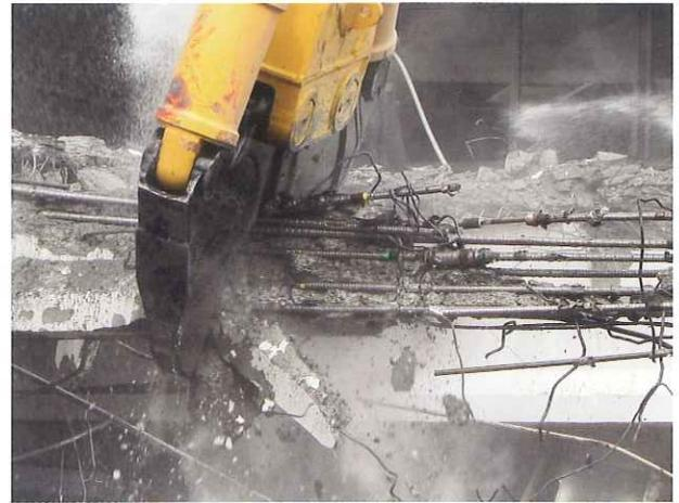
そしてもう一つのメリットは、やはりロングカッターブレードに関するのですが、多量の鉄筋切断が非常に楽であることです。写真の通り、この現場は通常のRC構造よりも2割以上は多いと思われる鉄筋が含まれていました。従来のようなRC用大割機の鉄筋用カッターでも対応できるのですが、やはり短いのでやりづらいことがあるのです。基礎や地中梁の内部鉄筋を切断する際ですが、大型の解体機の長いアームの奥にあるカッター部分を、鉄筋があるところまで突っ込みづらいのです。その際には、この540mmのロングカッターの長さが非常に有効です。つまり、アタッチメントを余り奥に突っ込まなくてもカッターブレードが容易に鉄筋に届くので切りやすいということです。
