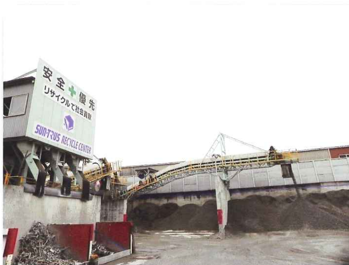
株式会社サントラス リサイクルセンター 新工場 処理量2400トン/日 千葉県市川市高谷2020番34号 TEL 047-327-2233
