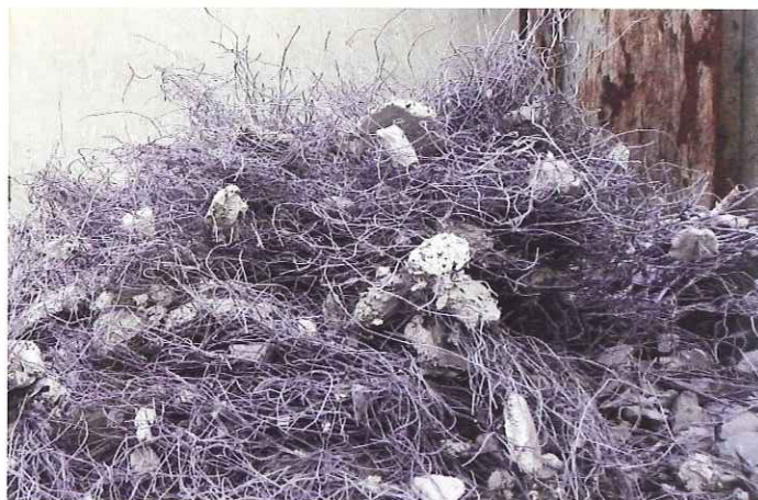
2次製品から発生する非常に細く鋭い鉄筋類をマグネットで回収（写真上）
