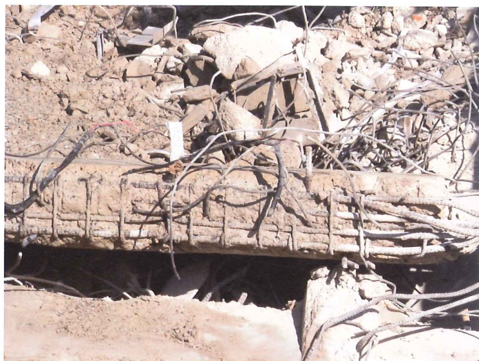
異形の太い鉄筋が大量に入っている鉄筋コンクリート梁をSDS150SRCアームで切断した。これが次世代型RC造ともい表現されるもの。
