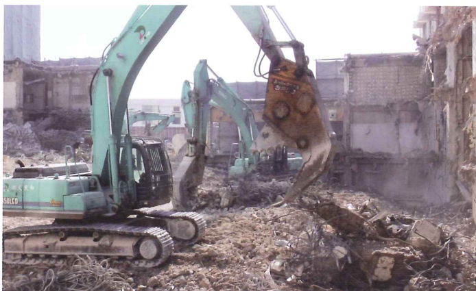
35トンクラスバックホウSK350に装着したパクラマグナム3200。45トンクラスにも装着できる。操作技術のおかげで軽さとスピード感を感じてしまう。
