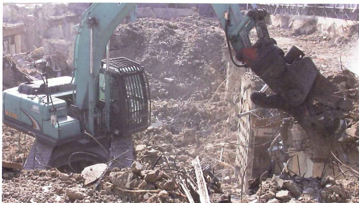
ウィザードVIP2200で「鉄筋コンクリートを切る」様子。鉄筋カッター長530ミリでスムーズに大量の鉄筋を切断してゆく。
