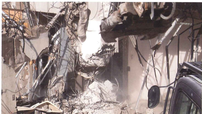
1000ミリのRC造柱を斜め方向から破碎する様子。SDS150SRCアームの破碎ツースとロングカッターを使いながら一気に切断した。
