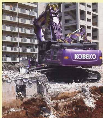
SK550 セパレートでペースアップした基礎の大割作業
