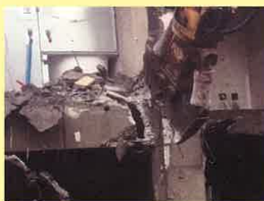
RC 梁の解体 (SDS30 ムサシアーム)
