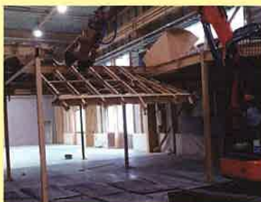
S 造倉庫内の中 3 階部分の解体 (SDS30SLC アーム)
