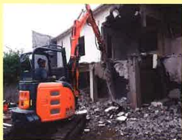
RC 造 2 階建ての住居の解体 (SDS30 ムサシアーム)
