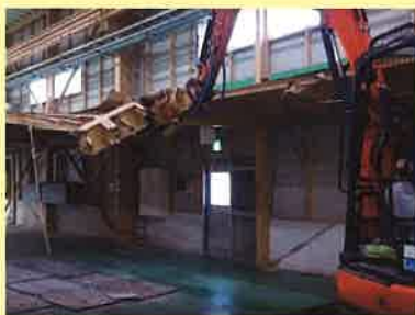
S 造倉庫内中 3 階部分の解体 (SDS30SLC アーム)
