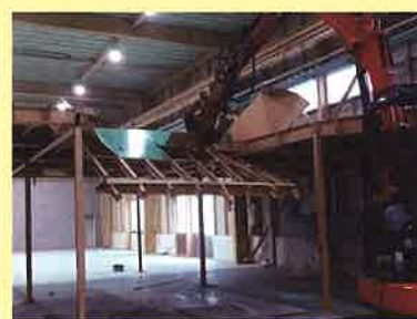
S 造倉庫内中3階部分の解体 (SDS30SLC アーム)
